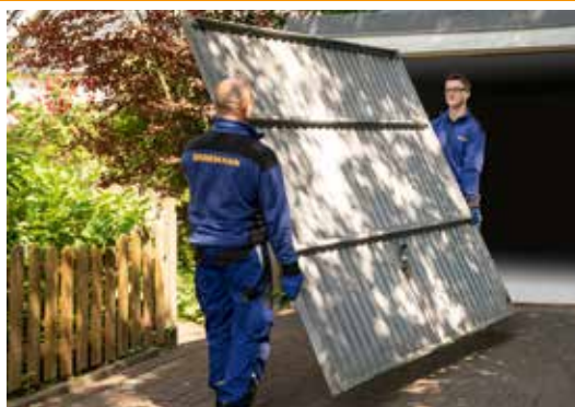
Ausbau und umweltgerechte Entsorgung
