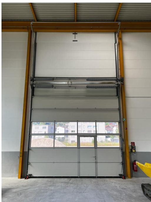
Industrie-Sektionaltor SPU F42 mit Schlupftüre Innenansicht
