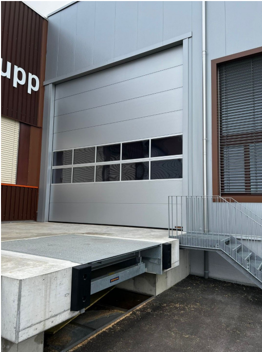
Industrie-Sektionaltor SPU F42 und Ladebrücke HTL2
